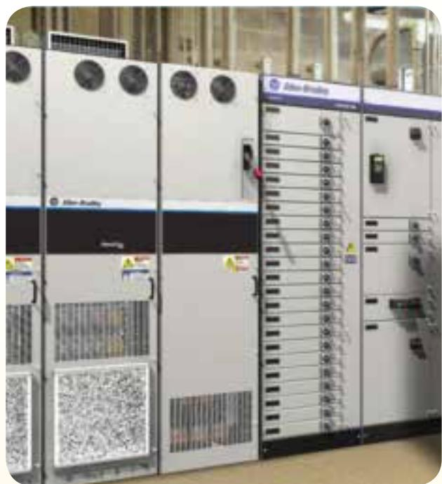
将 PowerFlex 755 地面安装式变频器和 MCC 连续并排安装，可减少机械部件数量，节省地面空间需求。
